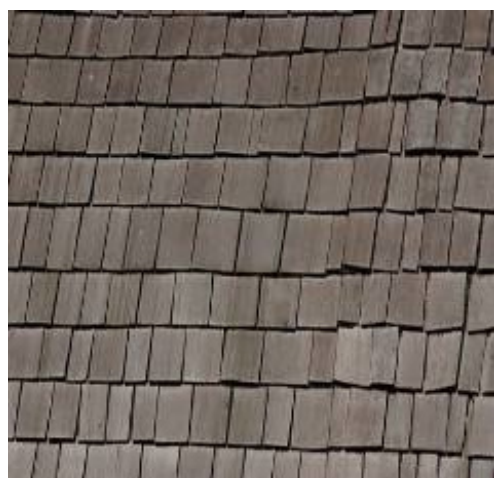
Bardeaux à Nantes
